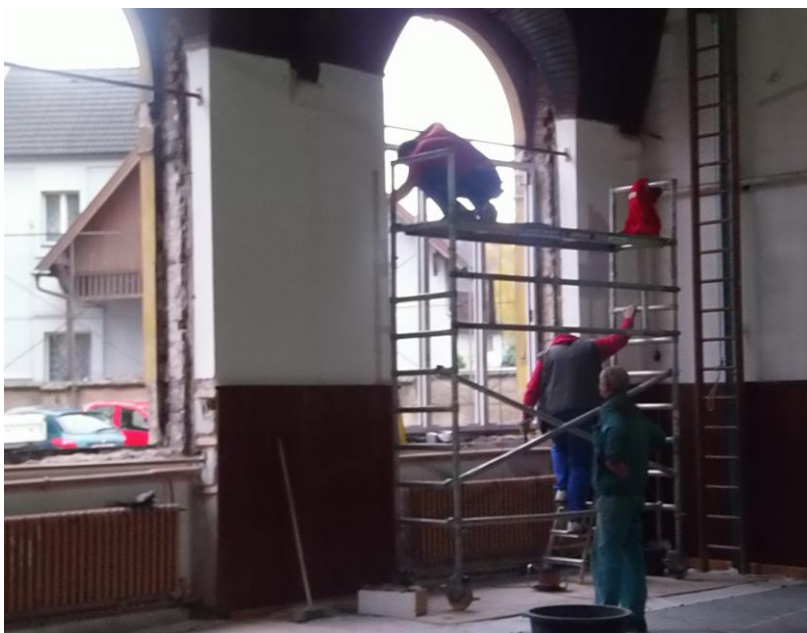
Výměna oken v tělocvičně
